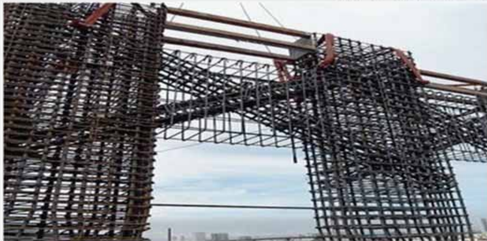
شکل ۲- نمونه ای از اجرای تیر همبند به همراه آرماتورگذاری قطری در مرکز آن [۳]
